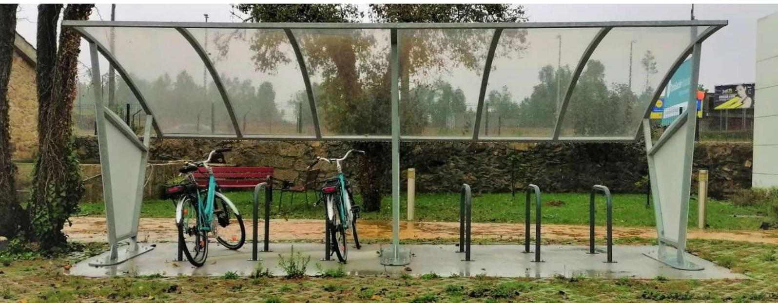
Alternativamente, os suportes poderão estar todos interligados entre si, ao nível do pavimento, facilitando a sua fixação. Quando um estacionamento para bicicletas for dotado de muitos suportes, devem ser criados corredores entre eles para facilitar o acesso e a retirada de bicicletas.
